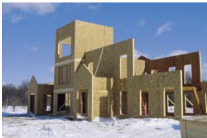
Príklady hrubých stavieb realizovaných technológiou SIPs v USA
