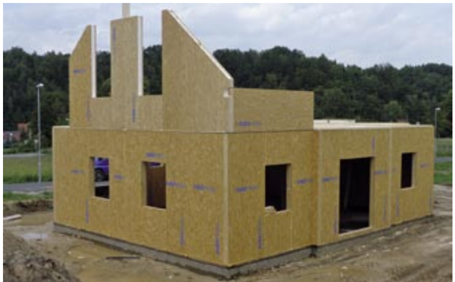
Montáž panelov druhého nadzemného podlažia
