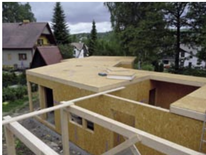
Použitie panelov SIPs na plášť plochej strechy
