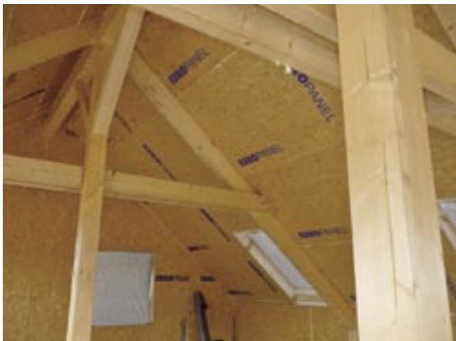
Detail podkrovia hrubej stavby domu s panelovou strechou
