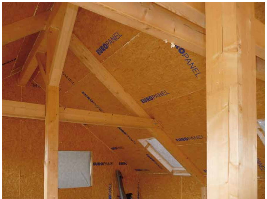
Obr. 4 Konstrukce krovu a střecha ze SIPs panelů – podkroví hrubé stavby dvoupodlažního domu se sedlovou panelovou střechou
