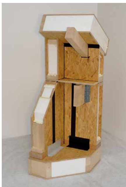
Obr. 7 Maketa – návaznost jednotlivých konstrukcí
